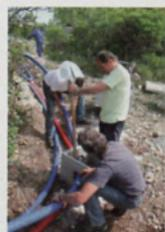
Ce ne sont pas moins de 25 à 30 personnes qui se retrouvaient au Castrum chaque mois et les travaux de calibrage du chemin, tranchée, installation des gaines et pose d'un lit de sable sont allés bon train.
